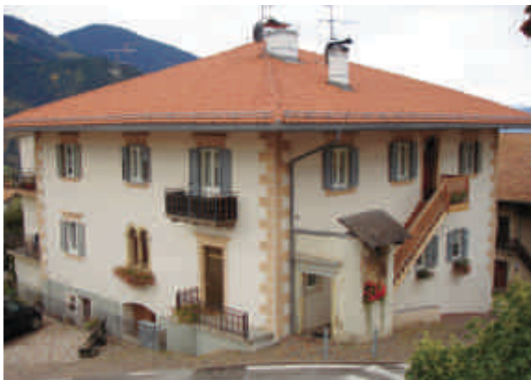
Fig. 1 - Casa Zen, in località Caltreza , a Tesero.
